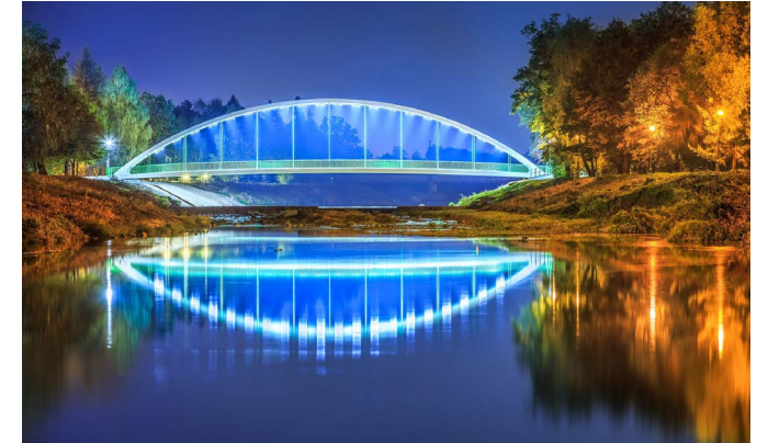
Kładka w rejonie ul. Sportowej po remoncie
