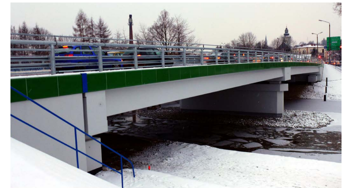
Most na ul. Bielskiej po remoncie
