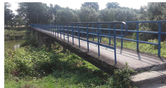
Kładka w Ochabach przed odbudową
