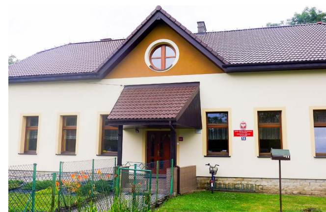
Przedszkole w Kiczycach po termomodernizacji
