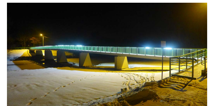
Kładka w Ochabach po odbudowie
