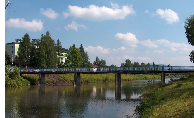
Kładka w rejonie ul. Sportowej przed remontem
