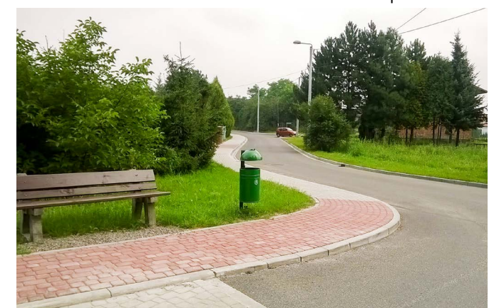
Ul. Krzywa i ul. Leśna po remoncie
