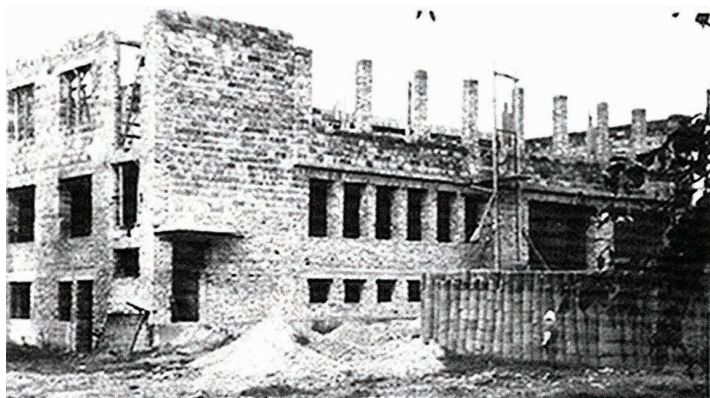
Nowa remiza w budowie – 8 lipca 1979 r.
