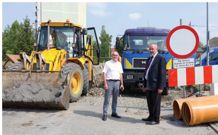
Burmistrz Skoczowa Mirosław Sitko na bieżąco sprawdza postępy prac na Górnym Borze
