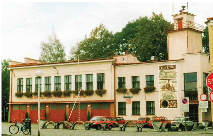
Trzeci budynek OSP, oddany do użytku w 1939 r.
